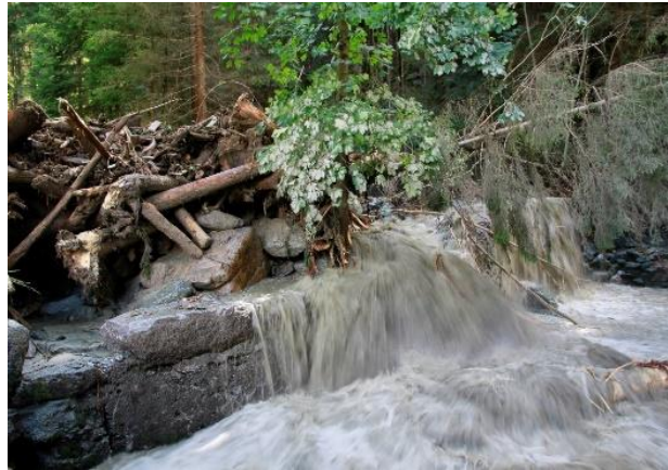
Abbildung 2: „Verklauserung“ an der Glems mit der Gefahr des Rückstaus und der Überflutung (Foto: Angelika Lugibihl)
