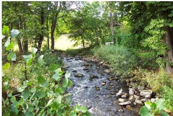
Abbildung 4: Renaturierungsmaßnahme an der Glems, Entschärfung eines Prallhangs durch Lenkung der Strömung mittels Steinbuhnen und Weidenfaschinen zur Sicherung des Prallhangs (Foto: Angelika Lugibihl)
