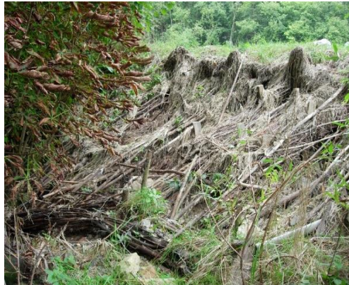
Abbildung 7: Hochwasserschaden 2005 an der Glems ohne Gefahr im Verzug (Foto: Angelika Lugibühl)
